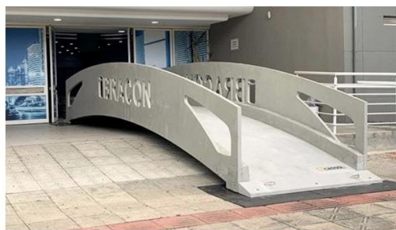
Figura 1.3 – Elementos produzidos com UHPC/UHPFRC no Brasil: (a) painéis de fachada do edifício do ERESP e (b) passarela pré-fabricada
